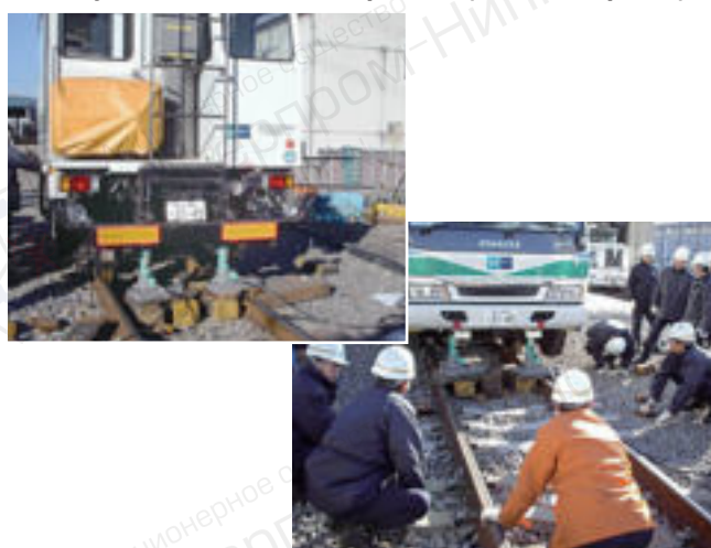
Гидравлический домкрат на скользящей опоре 230кН, 160мм и ручной насос TWA-0.7
