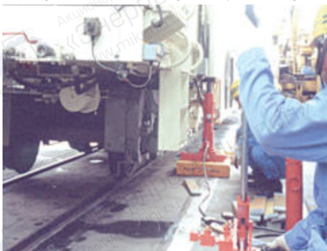
Гидравлический домкрат на скользящей опоре 300кН и ручной насос
