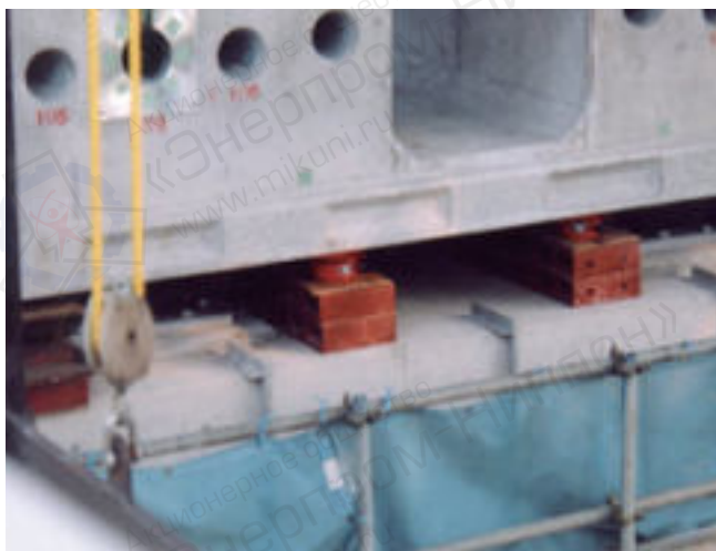
Низкий домкрат JFN200S3 с фиксирующей гайкой
