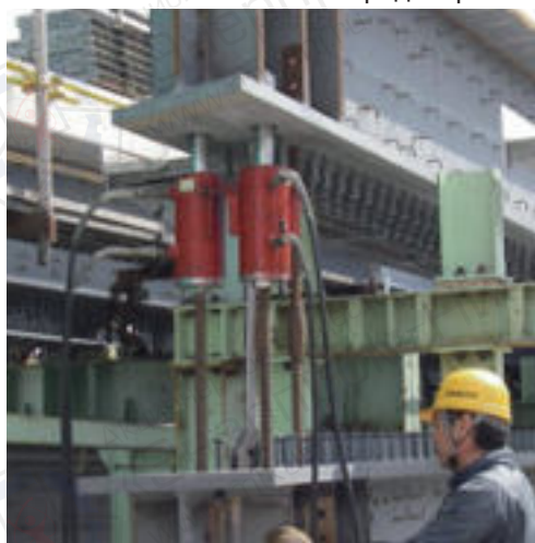
Домкрат гидравлический с полым штоком 1000кН
